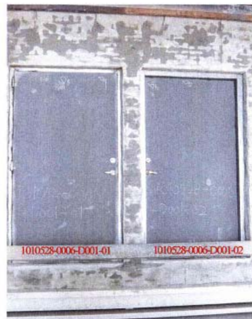
照片 5 加熱後試驗件非加熱面
